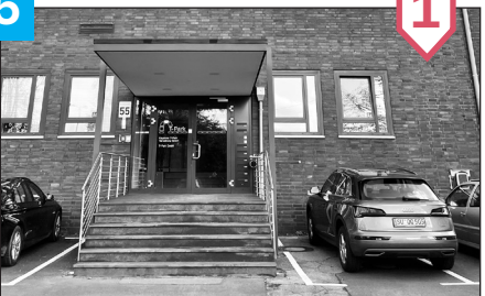
Building No. 315 / Gebäude Nummer 315 Management & Administration Geschäftsführung & Verwaltung Innovation & Technology Innovation & Technologie
