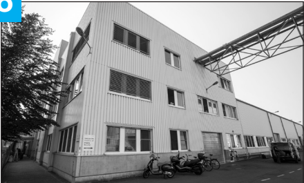
Building No. 296 / Gebäude Nummer 296 PVB Film Production, Quality Control PVB Folien Produktion, Qualitätskontrolle
