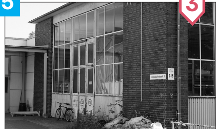
Building No. 315 / Gebäude Nummer 315 Equipment Warehouse / Ersatzteillager
