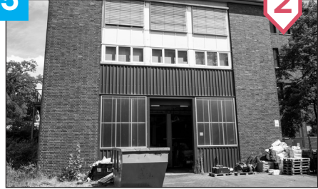
Building No. 315 / Gebäude Nummer 315 Equipment Warehouse, Bulky Goods Ersatzteillager, Sperrgut
