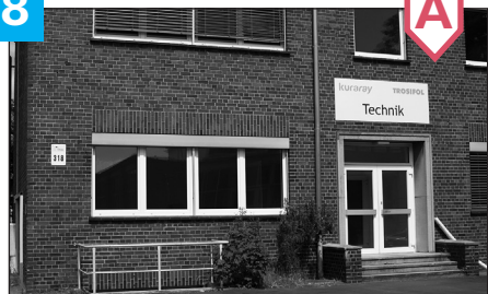
Building No. 318 / Gebäude Nummer 318 Maintenance / CIP, ESHA Occupational Safety Instandhaltung / CIP, ESHA Arbeitssicherheit
