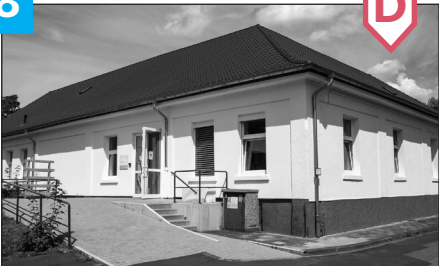
Building No. 318 / Gebäude Nummer 318 TS Lab Technical Service Labor
