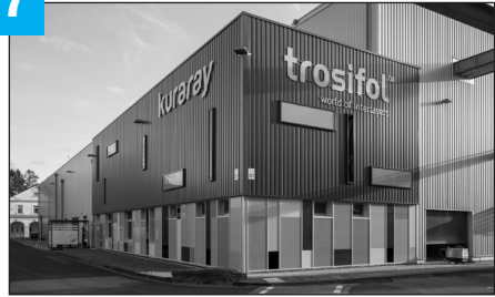
Building No. 327 / Gebäude Nummer 327 PVB Film Production PVB Folien Produktion
