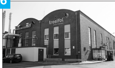
Building No. 416 / Gebäude Nummer 416 PVB Film Production PVB Folien Produktion
