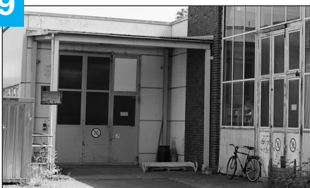
Building No. 319 / Gebäude Nummer 319 Equipment Warehouse Ersatzteillager
