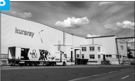
Building No. 288 / Gebäude Nummer 288 Product Warehouse, Truck & Container Loading Fertigerzeugnislager, LKW & Container-Beladung
